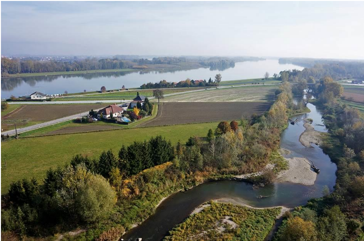
Abb. 112: Dynamischer Umgehungsarm am Donaukraftwerk Ottensheim-Wilhering. Aufgrund der hohen Abflussdynamik ( MQ = 6,3 \text{ m}^3/\text{s} , MJHQ \sim 140 \text{ m}^3/\text{s} im fotografierten Abschnitt) bleiben fließgewässertypische Schlüsselhabitate dauerhaft erhalten (Foto: TB Zauner GmbH).
